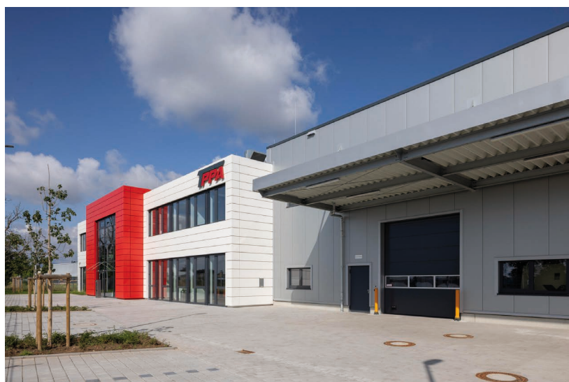
Bild 2: Die Turbine Power Plant Automation GmbH ist ein international agierendes Unternehmen im Bereich der Automatisierungstechnik im Kraftwerkssektor. © TPPA
