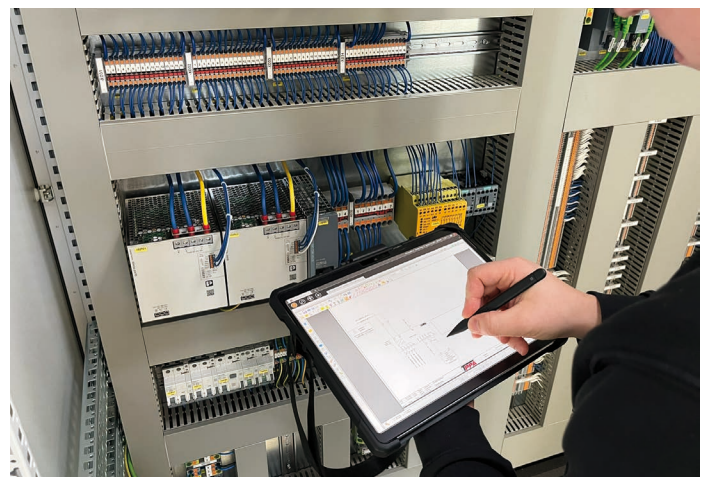
Bild 5: Der Inbetriebnehmer nimmt die Messwertaufnahme und Protokollierung vor Ort per Tablet vor. © TPPA
